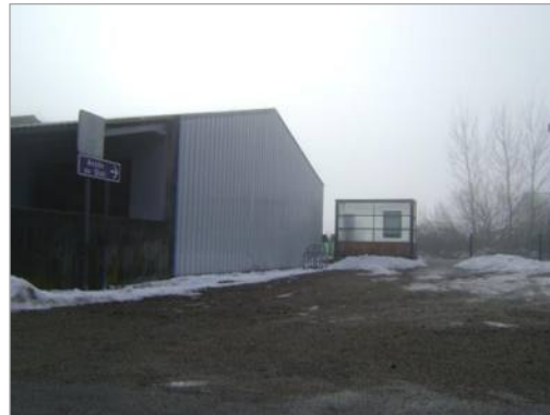
Les commerces de proximité ainsi que les infrastructures de transport (ferroviaire ici) permettent de développer la vie économique et sociale d'une commune.
